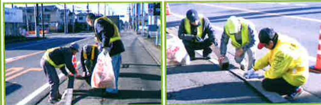
ポーソーシールの貼りつけ作業
